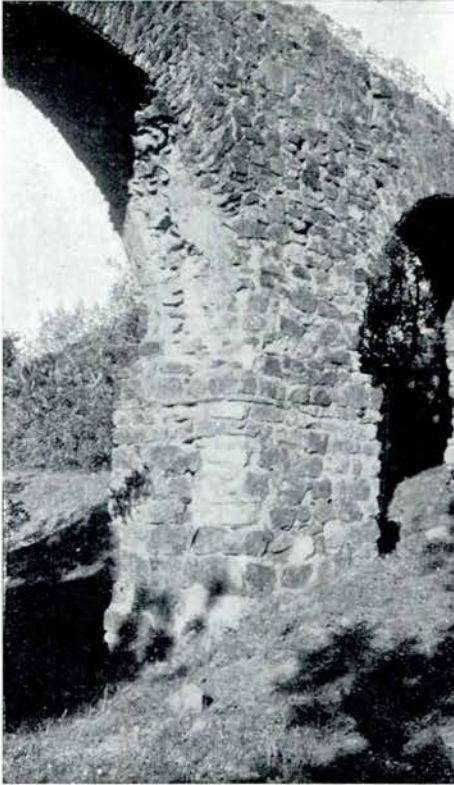
Fig. 10 - La primera pilastra del tros M. amb un sol arrasament. Es veu el major tamany i regularitat de les pedres i l'absència dels forats
