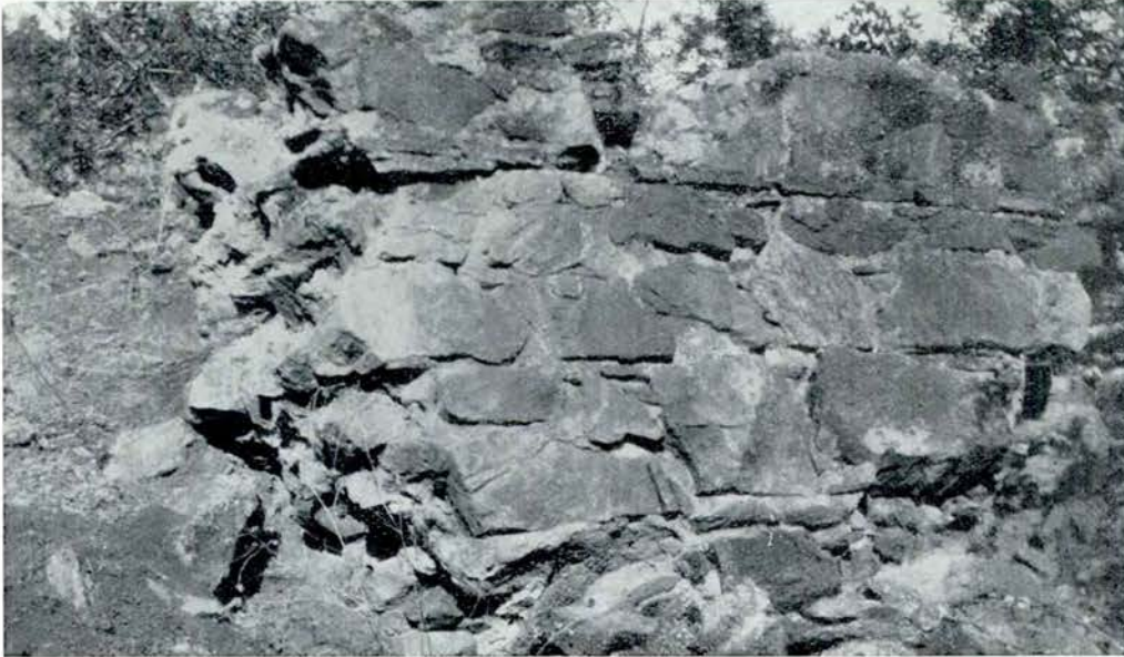
Fig. 3 - Tros de mur després Es poden veure les lloses sobre les quals hi ha el canal
