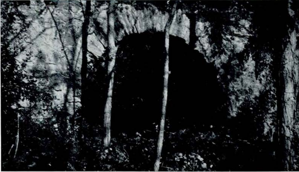
Fig. 12. - Arcada i part del mur G
